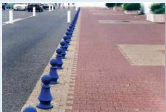
Chaussée réservoir. La collecte est assurée à travers des pavés poreux.
