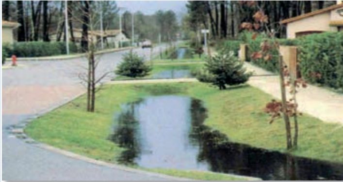
Noues et fossés : évacuation par débit régulé dans un réseau et/ou infiltration.
