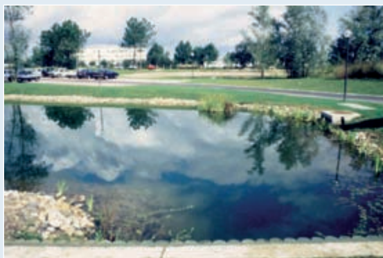
Bassin en eau.
