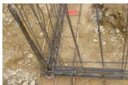
Nœud de chaînage - Continuité mécanique
