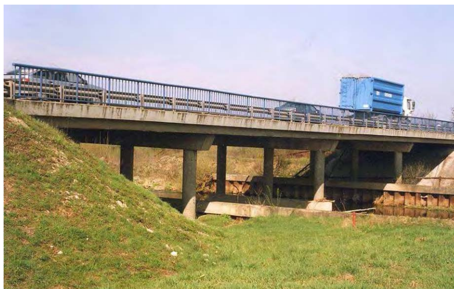
Ancien pont de la RN 19 sur l'OGNON
