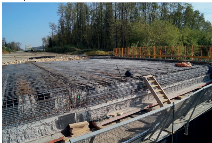
Ferrailage des deux demi-tabliers peu avant le bétonnage
