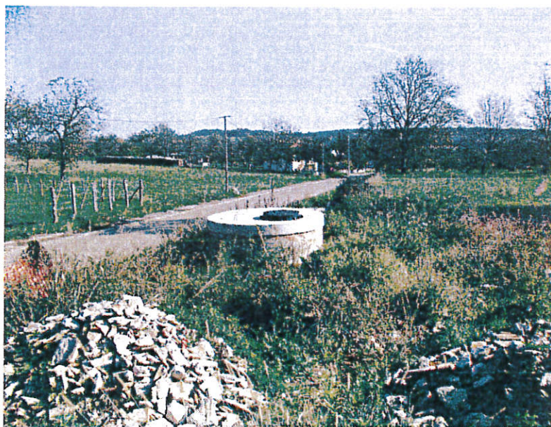
Illustration 9 – Effondrement tubé et aménagé en exutoire pour eaux pluviales sur la commune Oiselay-et-Grachaux
